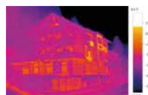
Warmtebeeld met testo ScaleAssist
